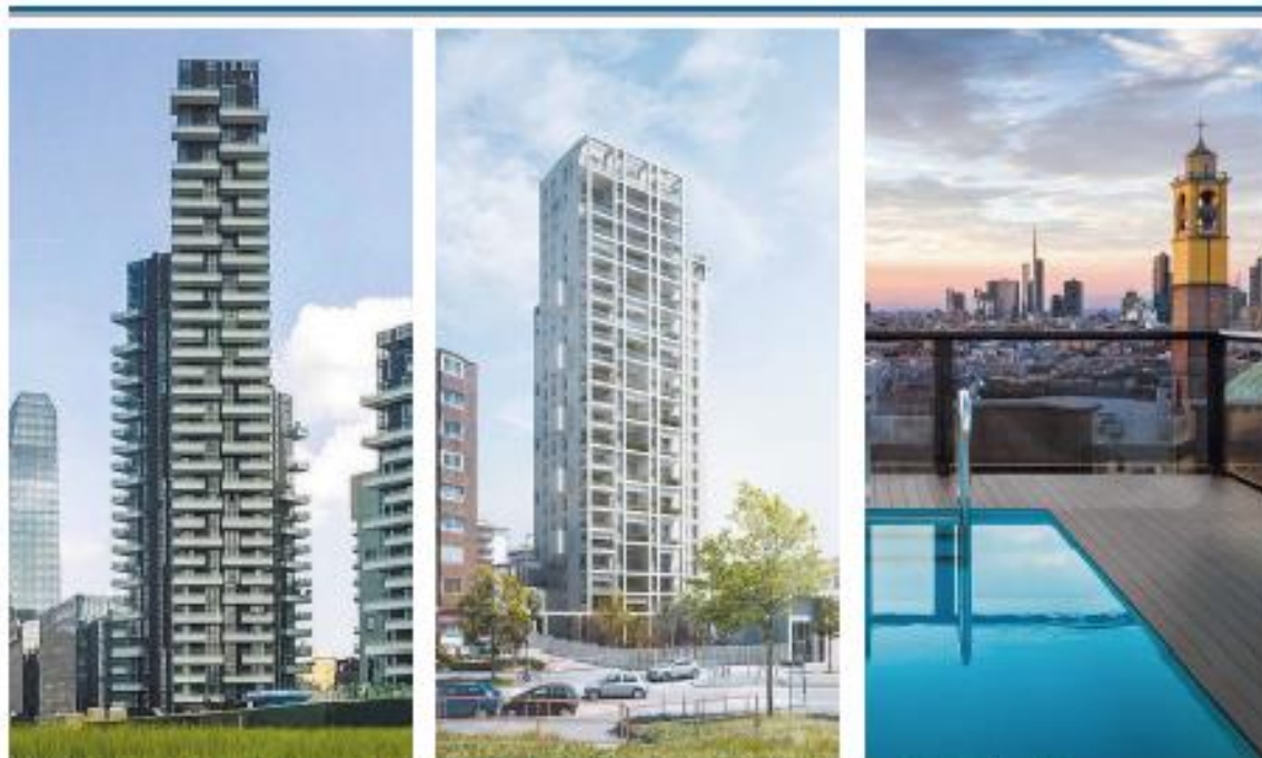
A sinistra la Torre Sobria, nel quartiere ex varesine; al centro la Torre Milano, in via Stresa; a destra, la vista dall'attico con piscina della Central Tower
